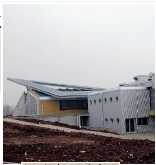
La struttura principale del grande Autoparco Brescia Est
