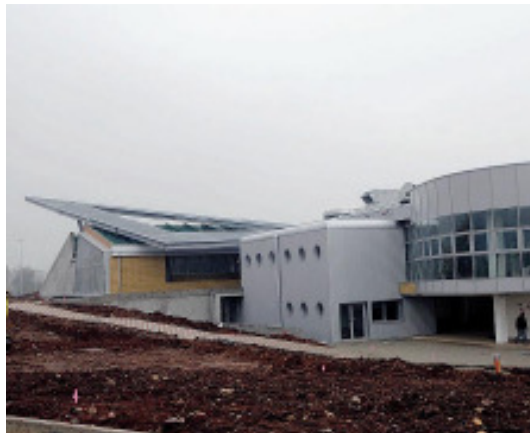
Il corpo degli edifici utilizzabili per i servizi in costruzione nell'autoparco di Brescia Est
